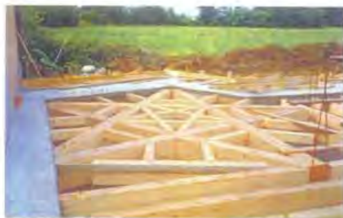
Orditura struttura lignea area pentagonale (sett 2001).
