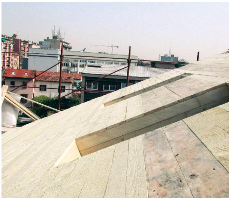
Sx dall'alto: fase di posa degli strati dei pannelli in fibra di legno (n°5 pannelli da cm 4) posati all'interno di una struttura di travetti "moralì" in abete (cm 10x10) con funzione di contenimento e sostegno all'assito superiore di chiusura;
